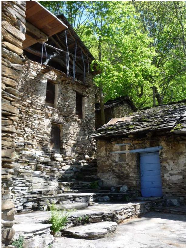
Della ventina abbondante di costruzioni ne restano ancora alcune con struttura sana e tetto a lose parzialmente integro, diverse sono ridotte a ruderi con tetto crollato.
