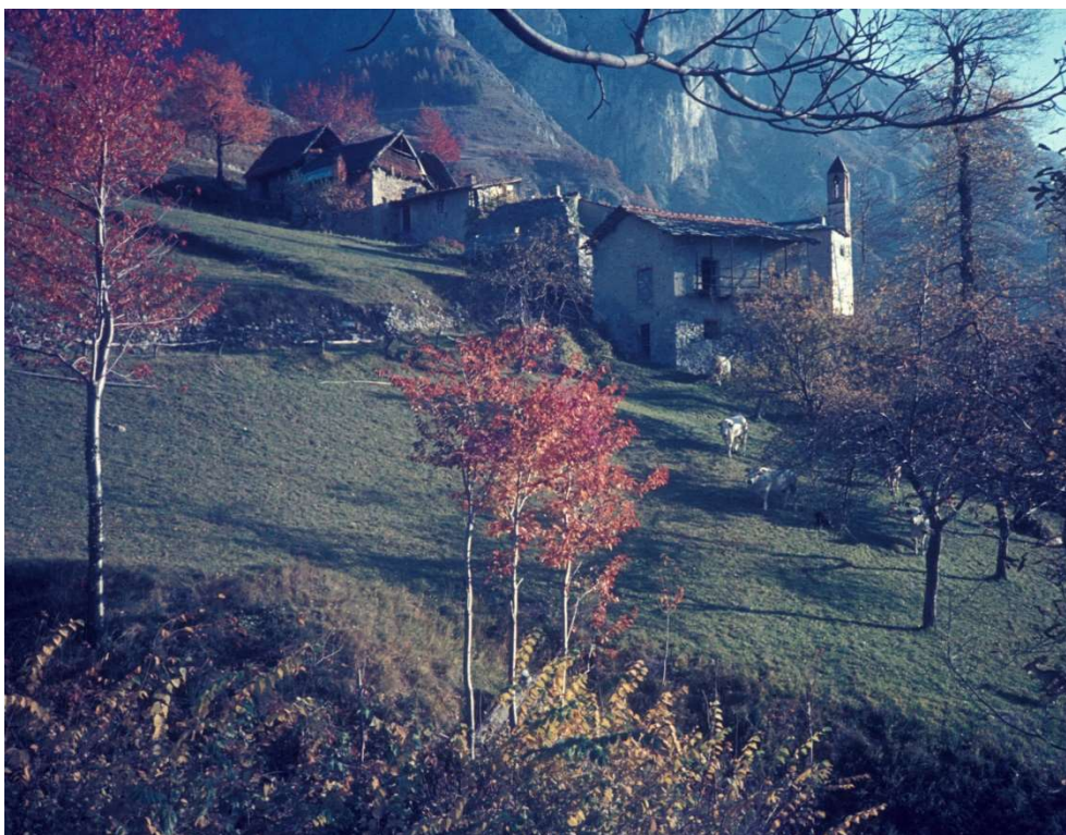
Piroùn di Aisone in una mia foto degli anni 80. Si notano in alto alcune case a gradino con tetto in paglia, mentre la casa in basso ha colmo orientato est-ovest e copertura a lose
